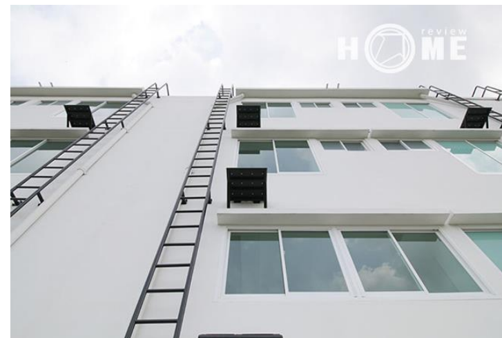
ด้านหลังบ้านมีบันไดหนีไฟ จากชั้น 3 ลงมาถึงบริเวณชั้นลอย (Fire escape from the 3rd floor down to the mezzanine area.)
